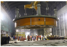
(数字液压应用于溪洛渡水电站施工现场)
